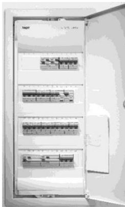
Infälld central Se 9.517
