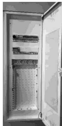
Infälld multimedia central Se 9.517
